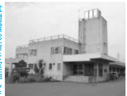
耐震診断を行う長浜学校給食センター
