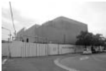
工事中のJR長浜駅舎
