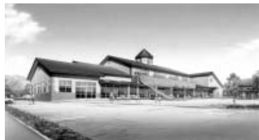
鉄骨2階建、延床面積1,818㎡、保育室（1階6室、2階3室）給本の部屋等あり
