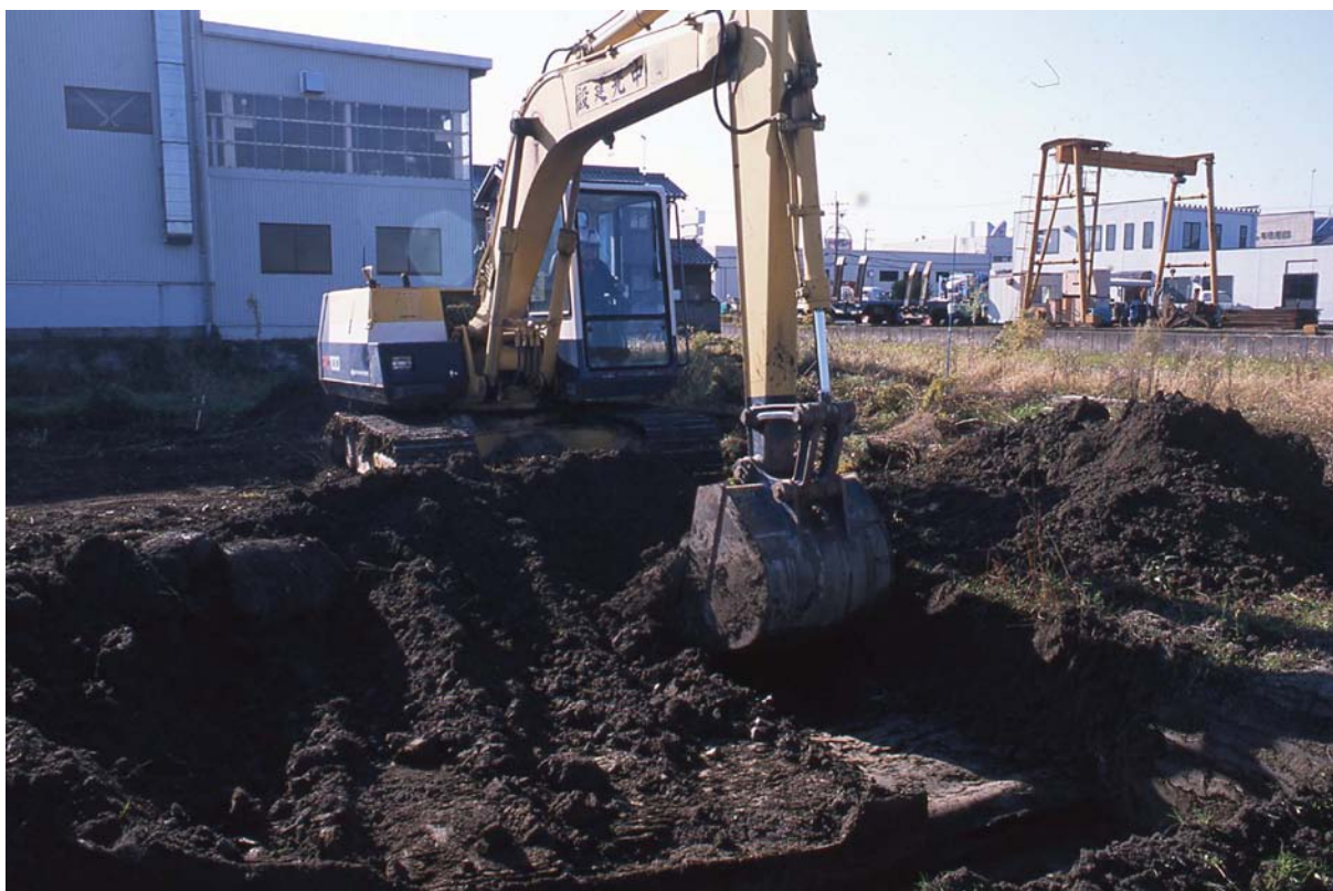
重機掘削状況（北から）
