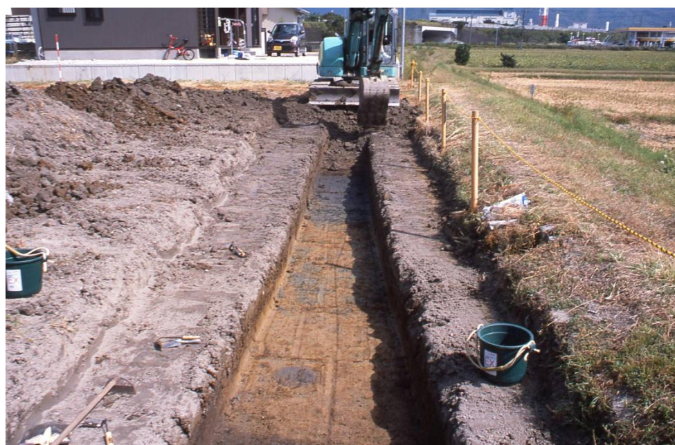
トレンチ 1 遺構検出状況 （西から）
