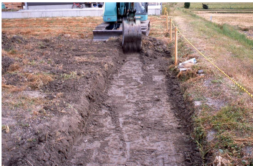
重機掘削状況（西から）
