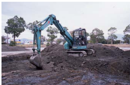
写真1 重機掘削状況
