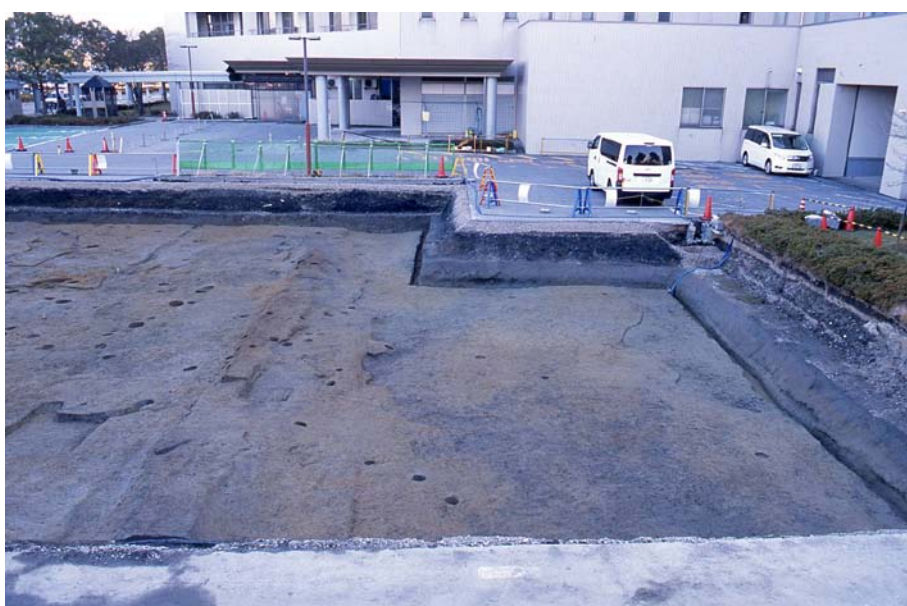
遺構完掘状況 西部 (北から)
