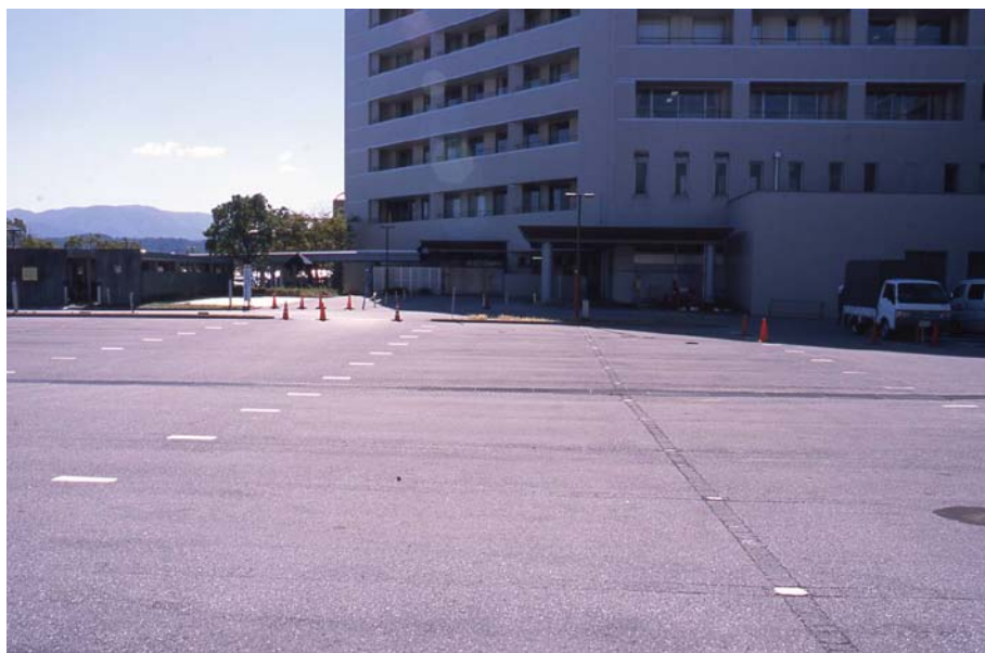
調査前状況 (北から)
