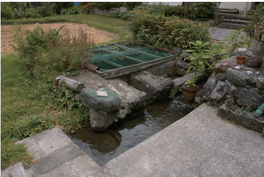
口絵6 菅並集落内の水路を屋敷地に引きこんだ洗い場（北東側から撮影）
