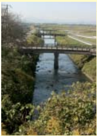
田川カルバートから下流を望む
