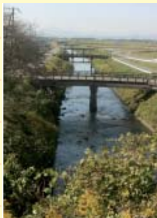
田川カルバートから下流を望む
