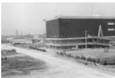
↑完成当時の様子。まわりにまだ何も建っていない。
