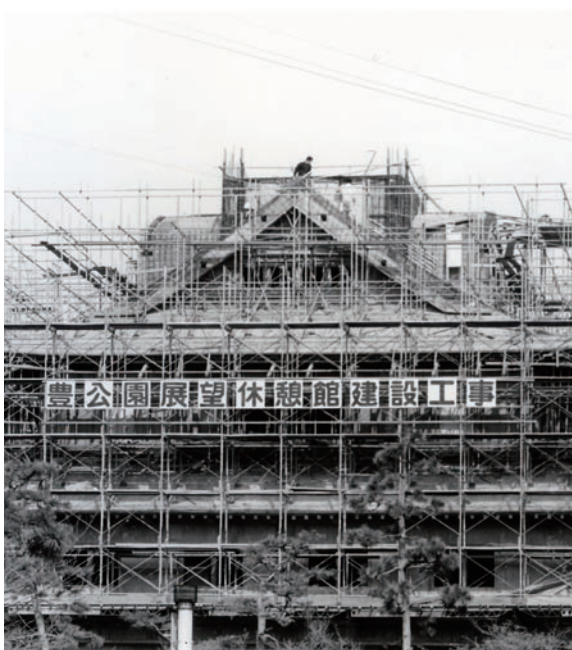
建設中の長浜城
