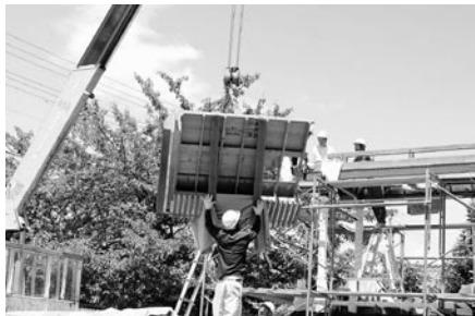
解体作業の様子（昨年8月）
