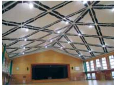
子どもたちの安全確保のため、地震時に落下する恐れのある吊り天井の落下防止対策工事を小学校4校、中学校3校で実施しました。
