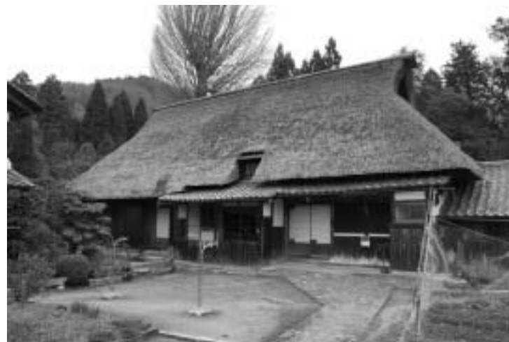
▲辻家住宅主屋 正面全景
