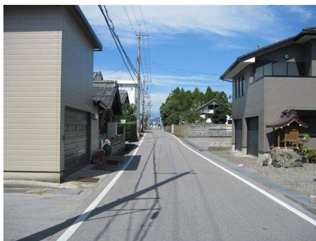
市街地の狭幅員道路（一般県道）
