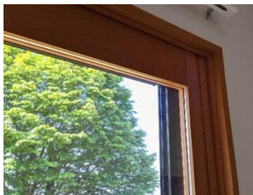
図 熱伝導率の低い木製サッシ・Low-E ペアガラスで断熱
