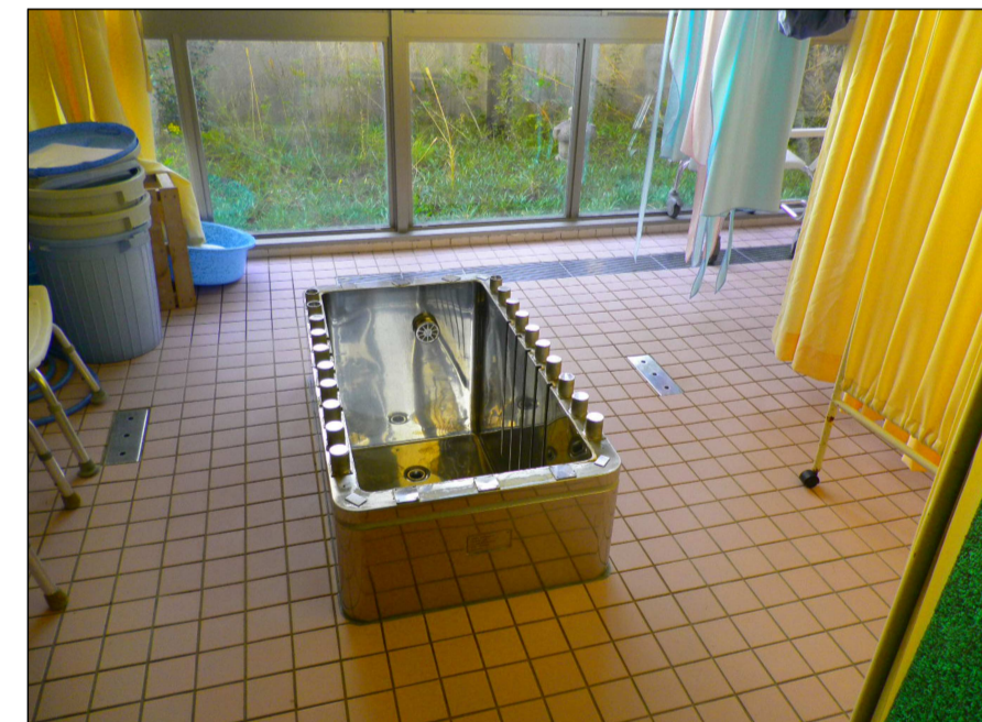
既設一人浴槽参考写真
