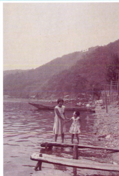
11 コサプロの浜。栈橋より小さく洗い場に利用された板をウマと呼びました。
