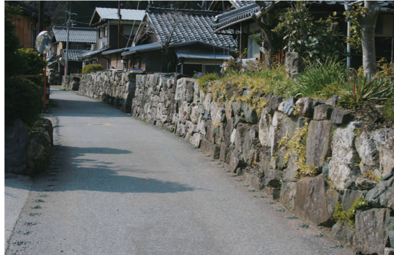
■住民の手によって築かれた石積。繰り返し修理しながら大事に残されています。
