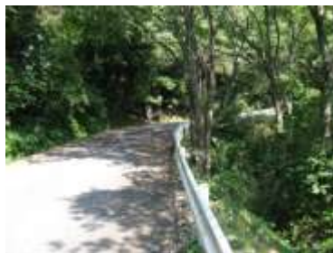
68 ガードレール カーブミラー
