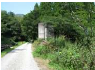
49 農業用水分水工
