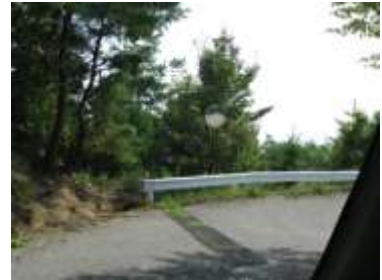
63 ガードレール カーブミラー
