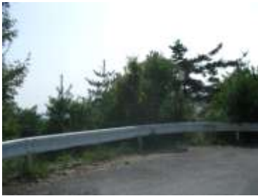
64 ガードレール カーブミラー
