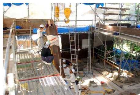
大通寺台所門 組立作業
