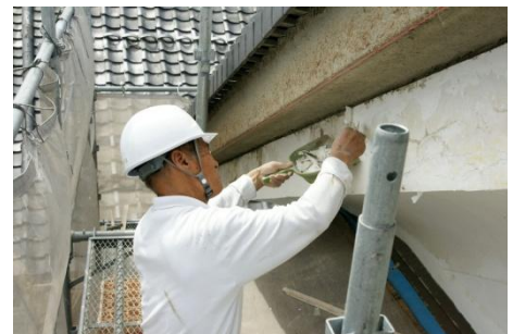
常磐山山蔵修理
