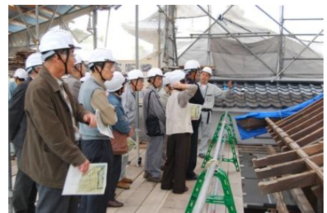
足場上での説明
