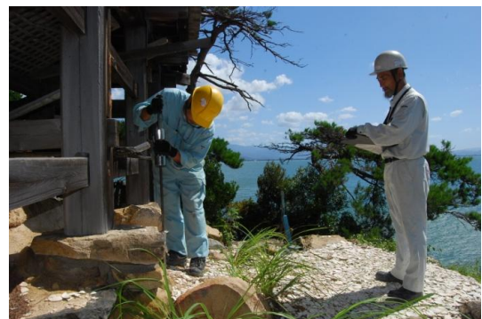
拝殿地盤調査状況
