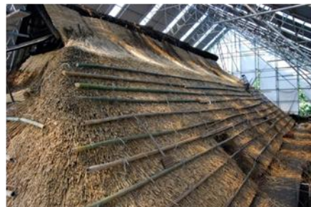
辻家住宅主屋 屋根修理 ヨシ葺施工
