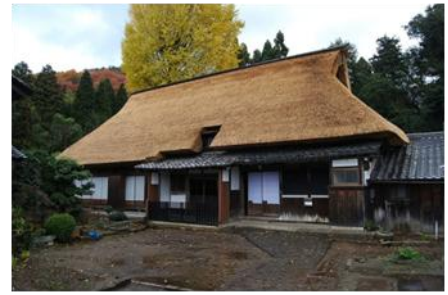
辻家住宅主屋 屋根修理 完成全景
