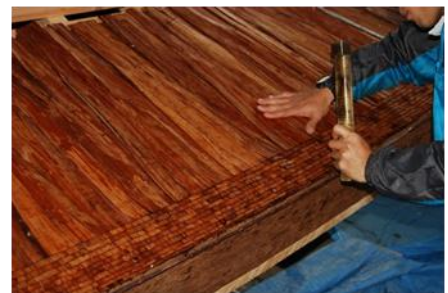
大通寺鐘楼 屋根修理 桧皮葺施工
