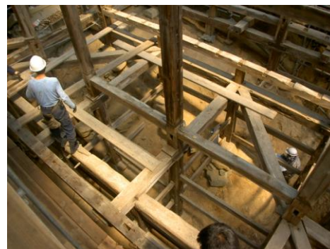
都久夫須麻神社拝殿解体状況
