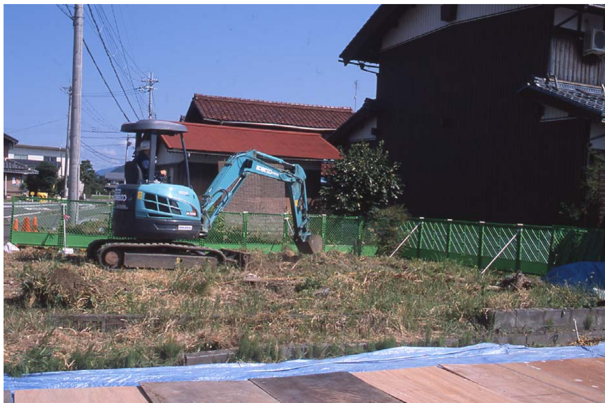
重機掘削状況（南から）
