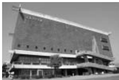
↑開館から43年が経過した現在の市民会館
