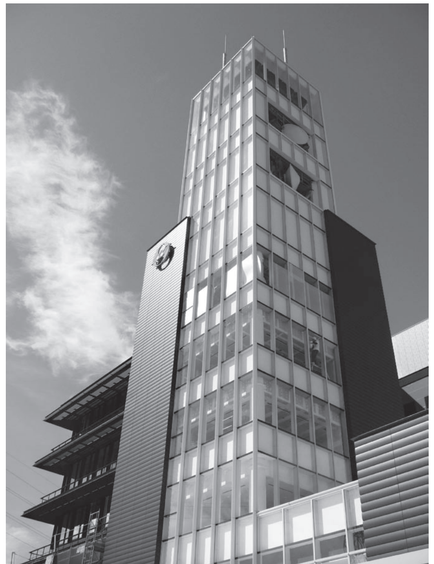
▶新庁舎東館(東側から撮影)
