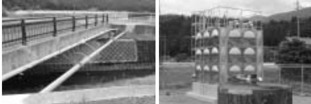
▲高野古橋水管橋
