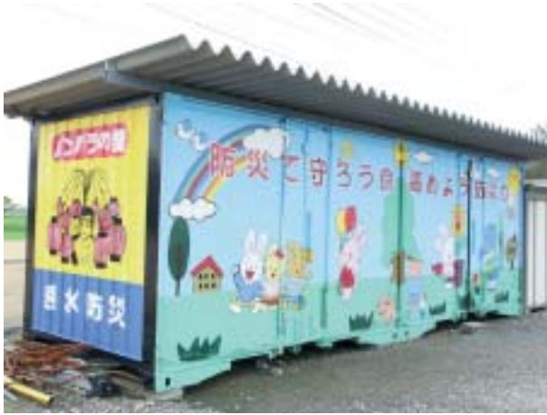
▶コンテナを改装して設置した防災資機材倉庫
