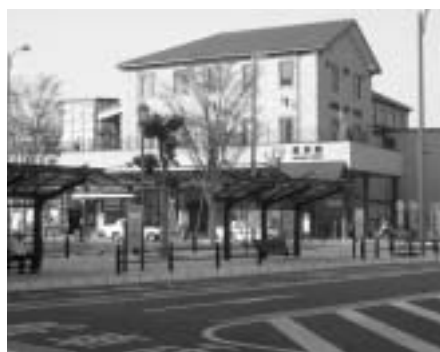
▲平成18年10月竣工の5代目の長浜駅(東口から)
