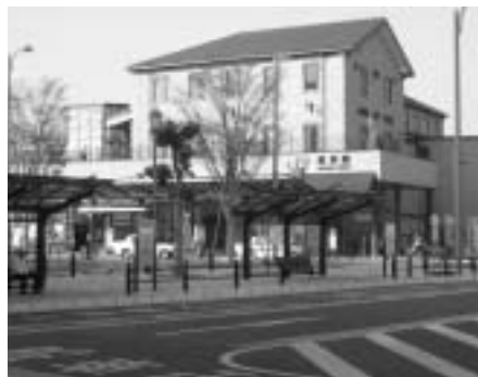
▲平成18年10月竣工の5代目の長浜駅（東口から）
