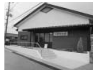
↑自治会館建設（八条町自治会）
