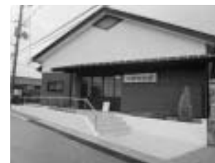
↑自治会館建設（八条町自治会）
