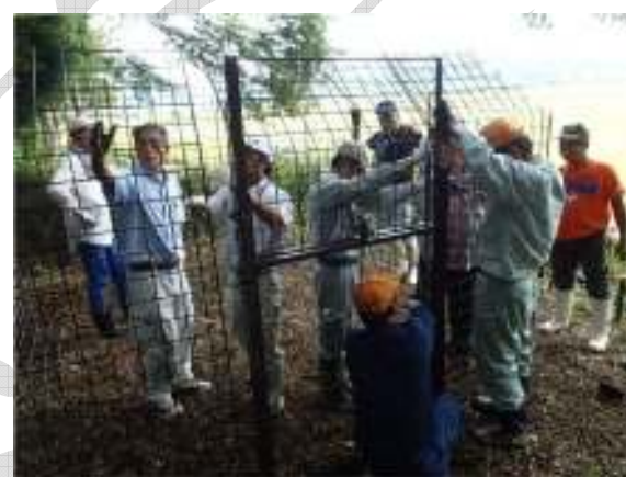
地元による防護柵の設置
