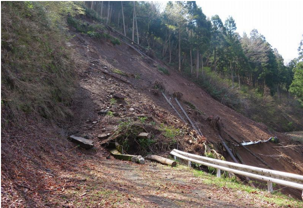
山腹崩壊の状況
