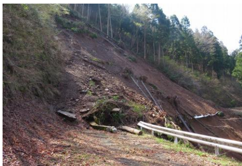
山腹崩壊の状況
