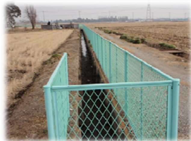
安全柵の設置
