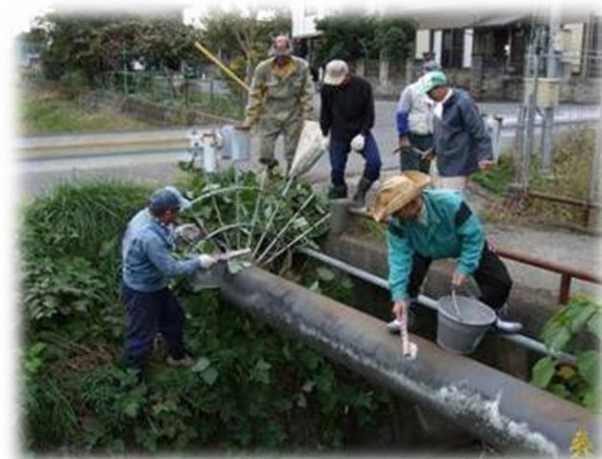
水管橋の塗装中
