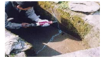
水路のひび割れ補修
