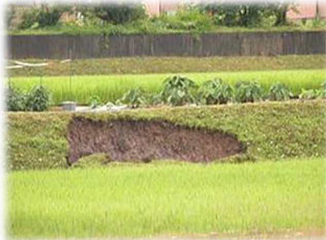
法面の崩壊の復旧
