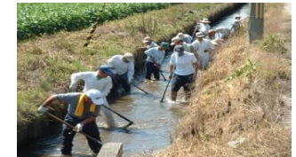
水路の泥上げ
