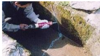
水路のひび割れ補修
