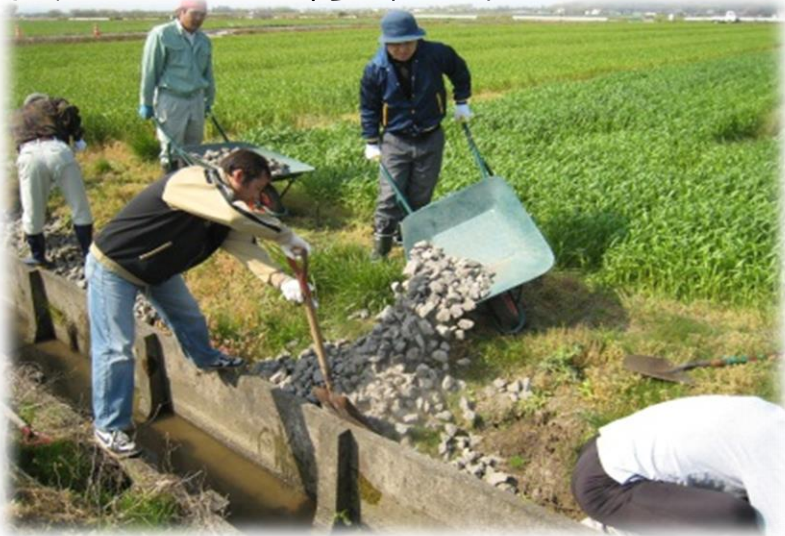
排水路の修繕中
