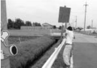
▲違反広告物の撤去作業(昨年)
