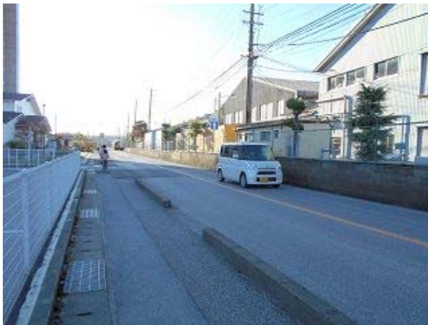
歩道に凸凹があり、車いすの通行が困難
