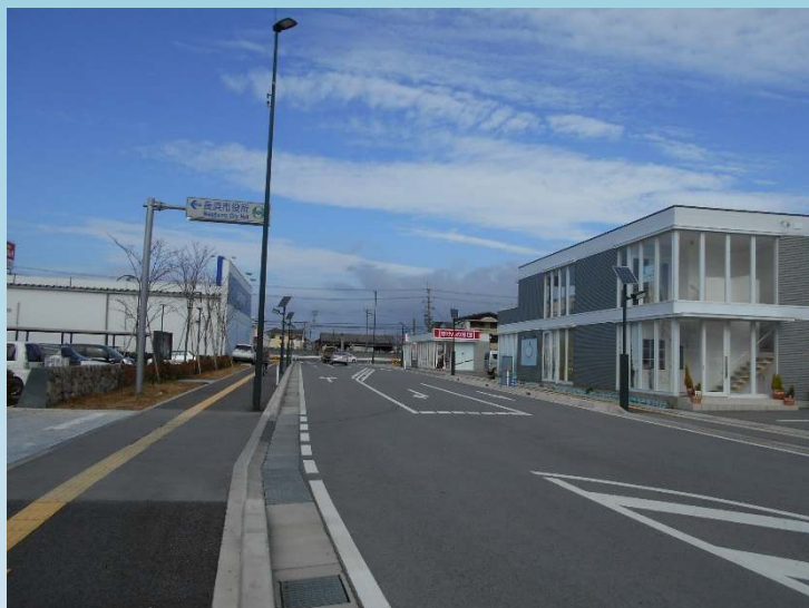
図-1 都市計画道路地福寺神照線（市役所東側）
