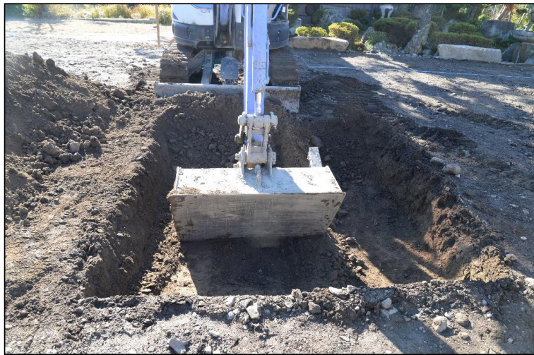
石田氏館遺跡第19次調査 重機掘削状
