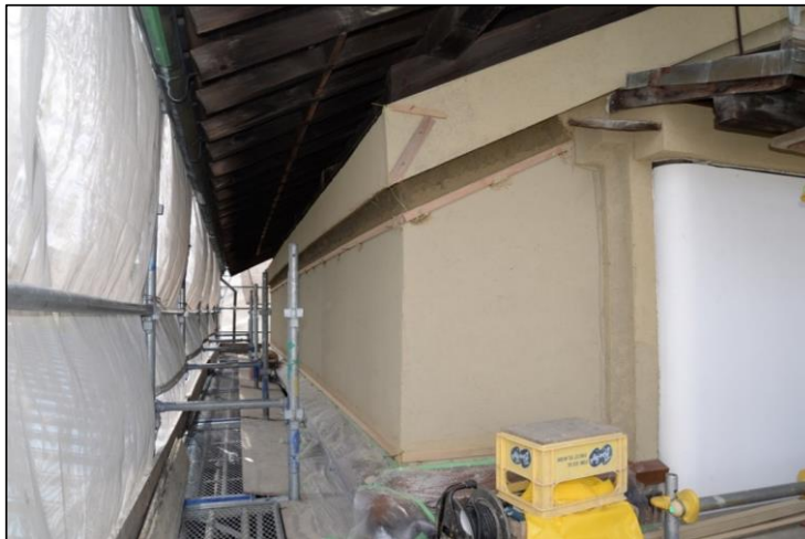
漆喰壁の塗り替え
