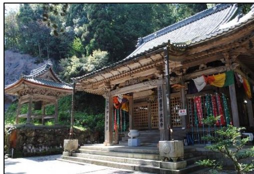
日吉神社観音堂（赤後寺） 入母屋造、棧瓦葺 明治5年（1872）建築（文書）
