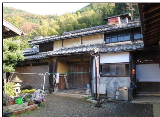
菅浦家住宅主屋 木造2階建、瓦葺 安政年間(1854~1859)建築(棟札)
