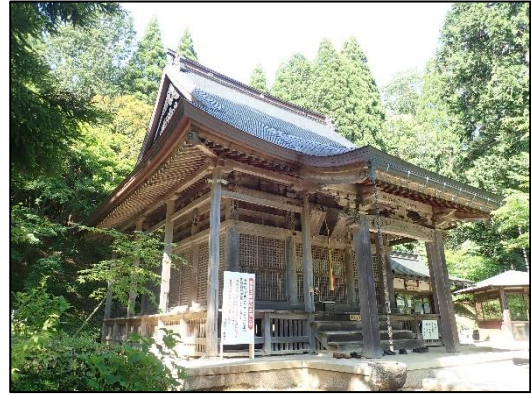
石道寺 入母屋造、鋼板葺 大正3年(1914)建築(文書)
