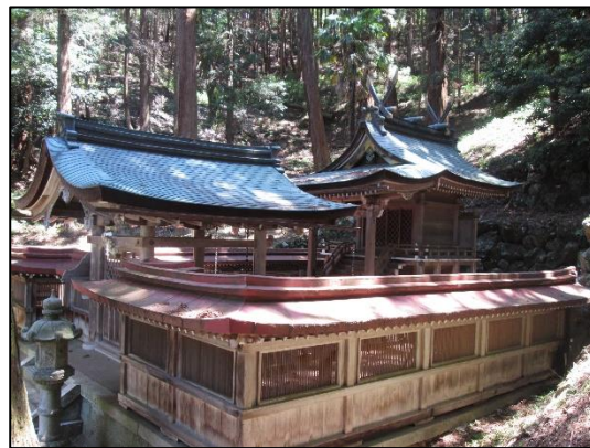
走落神社 本殿 春日造、銅版葺 大正15年（1926）建築（文書）
