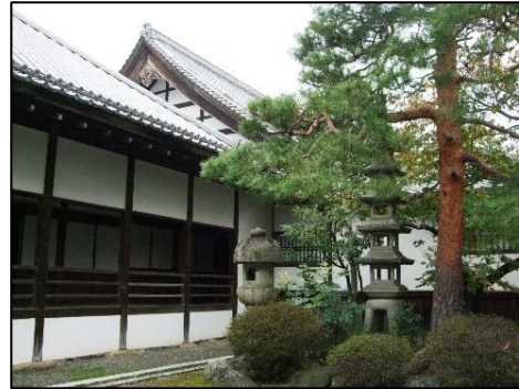
大通寺新御座 正面切妻造、背面入母屋造、棧瓦葺 大正元年（1912）建築（文書）
