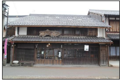
ダイコウ醤油主屋 木造2階建、瓦葺 江戸時代後期建築（調査報告書）
