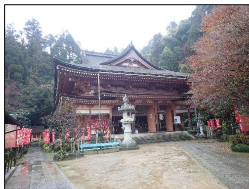
宝巖寺弁才天本堂 一重、入母屋造、檜皮葺 昭和17年（1942）建築（記念碑）
