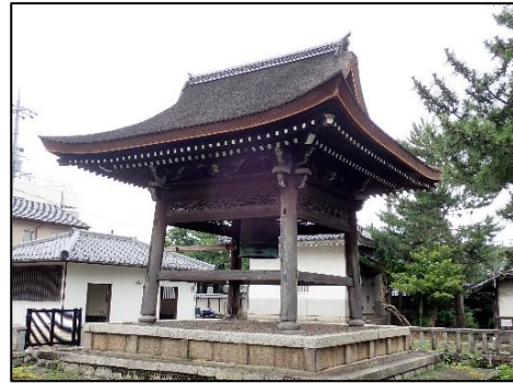
大通寺鐘樓 入母屋造、檜皮葺 延宝3年(1675)建築(棟札)
