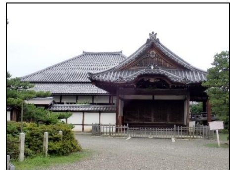
大通寺広間 一重、寄棟造、本瓦葺及び棧瓦葺 宝暦10年（1760）建築（棟札）
