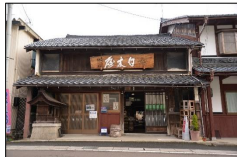
白木屋醤油店主屋 木造2階建、瓦葺 江戸時代後期建築（調査報告書）
