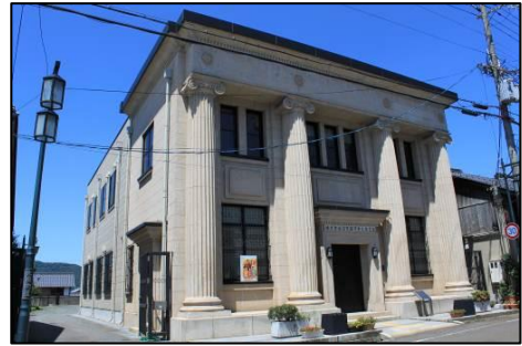
木之本町きのもと交遊館 鉄筋コンクリート造 昭和10年（1935）建築（調査報告書）
