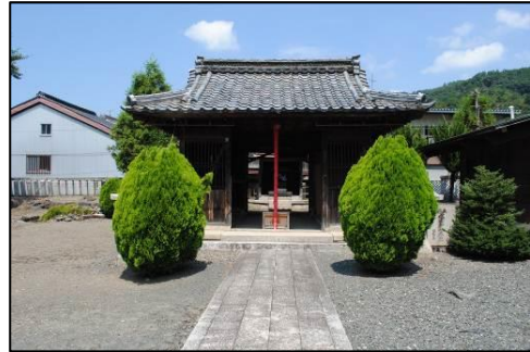
浄信寺秋葉堂 入母屋造、棧瓦葺 江戸時代後期建築
