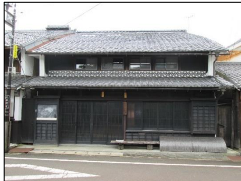
橋本家住宅主屋 木造2階建、瓦葺 安政年間（1855～1860）建築（調査報告書）
