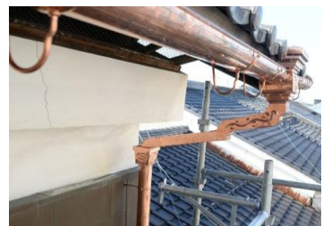
施工後(樋取り替え後)
