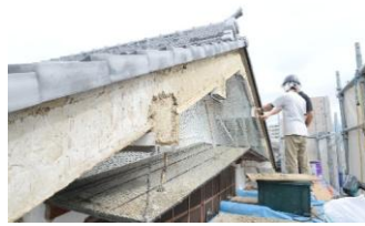
施工中 (漆喰掻き落とし状況)
