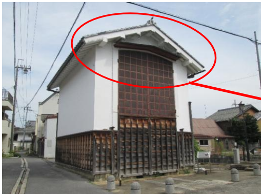
長浜曳山祭 諫鼓山山蔵(漆喰の剥落修繕)
