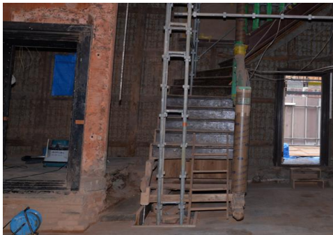
金庫室の劣化したレンガを撤去し、柱や壁を改修。
