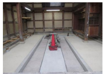
施工後(土間三和土仕上げ)
