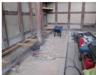
施工中(土間解体状況)
