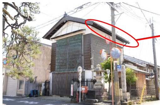
長浜曳山祭 翁山山蔵(樋修繕等)
