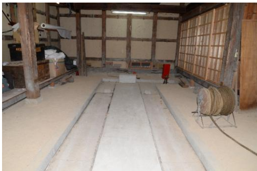
長浜曳山祭 春日山山蔵(土間修繕)
