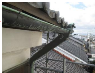
施工前(樋取り替え前)
