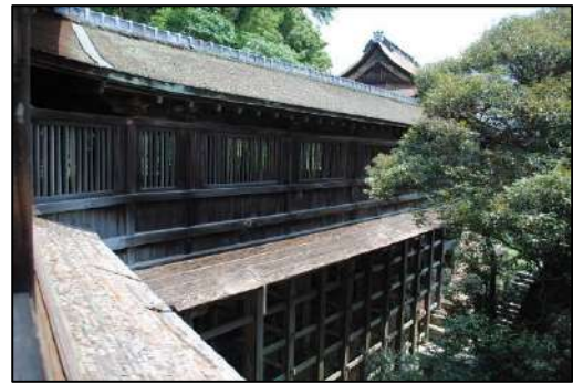
宝厳寺渡廊（手前：低屋根、奥：高屋根） 一重、切妻造、檜皮葺 慶長8年（1603）建築（棟札）
