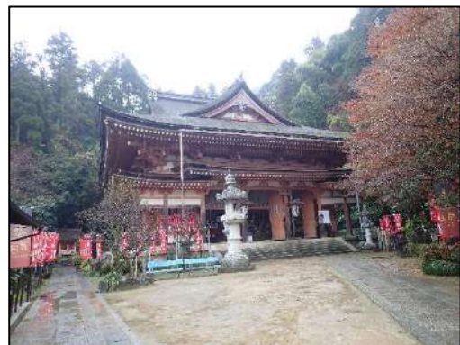
宝厳寺弁才天本堂 一重、入母屋造、檜皮葺 昭和17年（1942）建築（記念碑）
