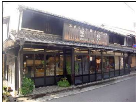
和菓子屋「萬與」 木造 2 階建、瓦葺 嘉永 7 年（1854）建築（棟札）
