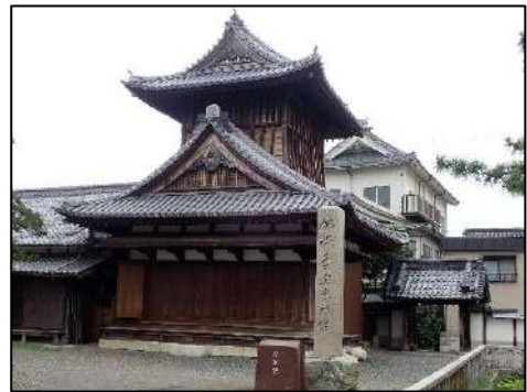
大通寺太鼓楼 入母屋造、本瓦葺 19世紀前半建築(建築様式)
