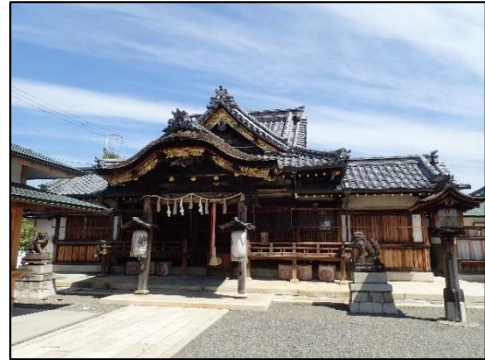
豊国神社拝殿 入母屋造千鳥破風付、棧瓦葺 明治31年(1898)建築(文書)
