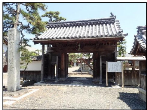
知善院表門 三間一戸、棟門、本瓦葺 桃山時代（16世紀後期）建築（建築様式）
