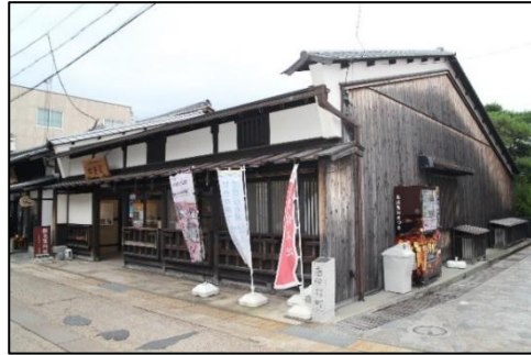
旧四居家住宅主屋（観光情報センター） 木造平屋建、鉄板葺 江戸時代中期建築（調査報告書）
