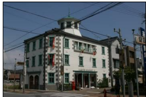
長浜旧開知学校 木造3階建、瓦葺、塔屋付 明治7年（1874）建築（棟札）
