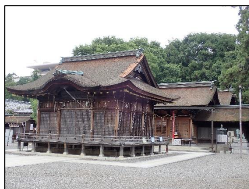
長濱八幡宮本殿・幣殿・拝殿 明治22年(1889)建築(文書)
