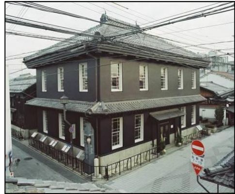
黒壁ガラス館本館（旧第百三十銀行長浜支店） 木造2階建、瓦葺 明治33年（1900）建築（棟札）
