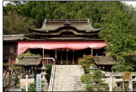
都久夫須麻神社 本殿 一重、入母屋造、檜皮葺 永禄 10 年(1567) 建築(棟札)
