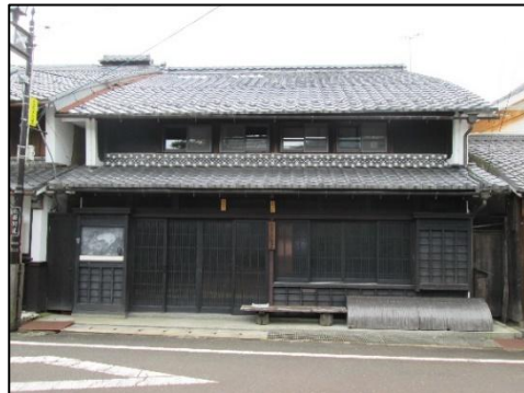
橋本家住宅主屋 木造2階建、瓦葺 安政年間（1855～1860）建築（調査報告書）
