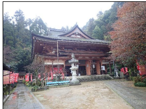
宝巖寺弁才天本堂 一重、入母屋造、檜皮葺 昭和17年（1942）建築（記念碑）
