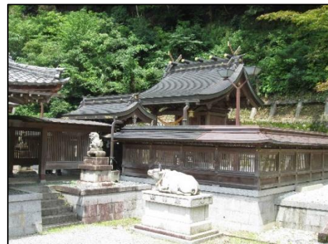
意富布良神社本殿 一間社流造、銅板葺 大正14年(1925)改築
