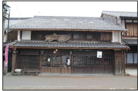
ダイコウ醤油主屋 木造2階建、瓦葺 江戸時代後期建築（調査報告書）
