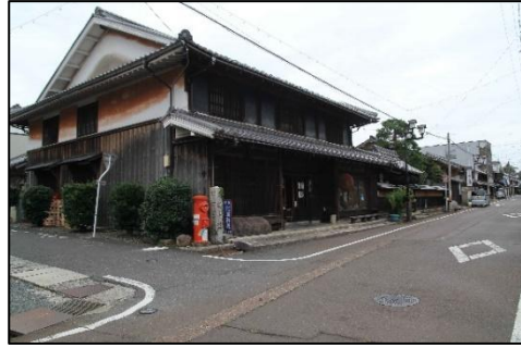
山路酒造主屋 木造2階建、瓦葺 昭和3年（1928）建築（文書）
