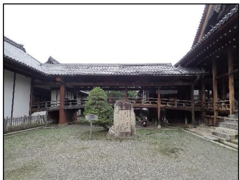
大通寺渡廊 切妻造、棧瓦葺 18世紀後期建築(建築様式)
