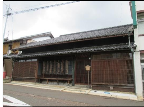
竹内家住宅主屋 木造平屋建、瓦葺 延享元年（1744）建築（棟札）
