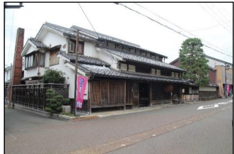
富田酒造主屋 木造2階建、瓦葺 延享元年（1744）建築（文書）
