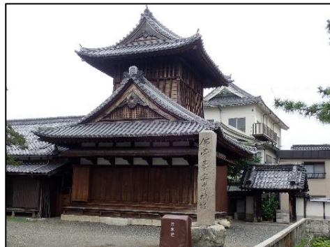
大通寺太鼓樓 入母屋造、本瓦葺 19世紀前半建築(建築様式)
