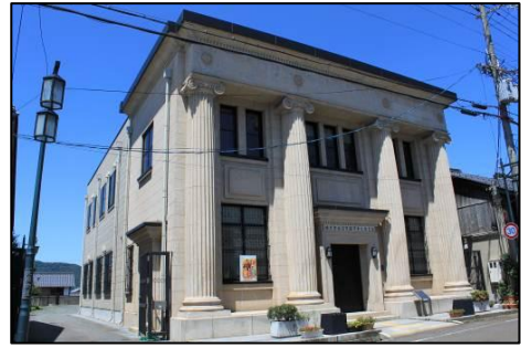
木之本町きのもと交遊館 鉄筋コンクリート造 昭和10年（1935）建築（調査報告書）
