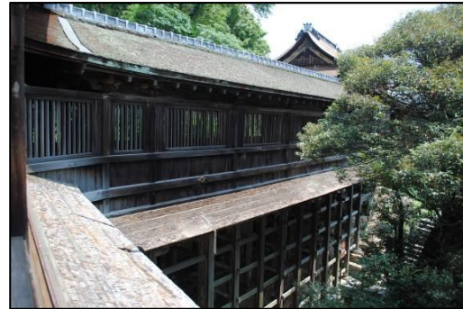
宝巖寺渡廊（手前：低屋根、奥：高屋根） 一重、切妻造、檜皮葺 慶長8年（1603）建築（棟札）
