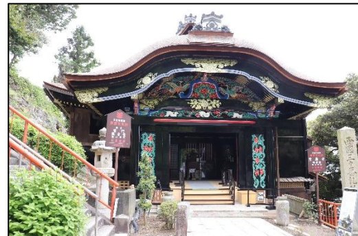
宝厳寺唐門(手前)、観音堂(奥) 唐門：一間一戸向唐門、檜皮葺 観音堂：一重、入母屋造、檜皮葺 慶長 8 年(1603) 建築(棟札)(唐門は移築)
