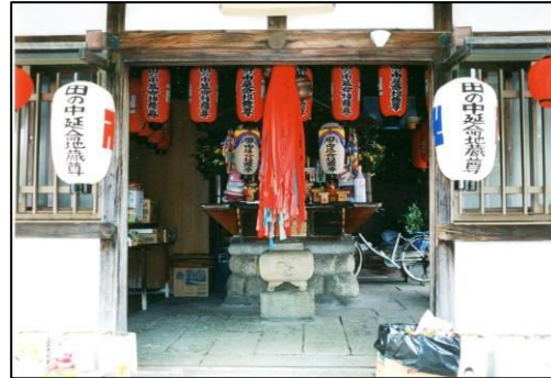
田の中延命地蔵尊 地蔵堂 入母屋造、棧瓦葺 明治11年(1878)建築(棟札)
