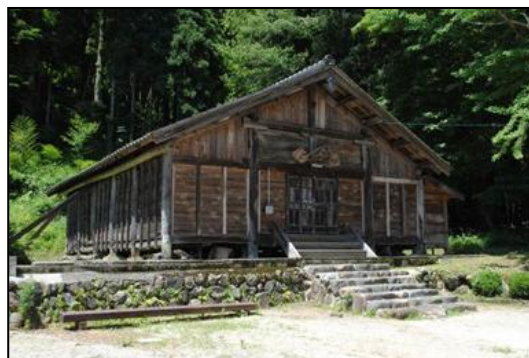
杉野中薬師堂 一重、切妻造、棧瓦葺 室町後期建築（建築様式）
