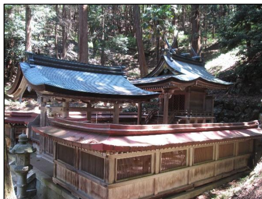
走落神社 本殿 春日造、銅版葺 大正15年（1926）建築（文書）
