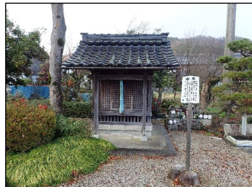
西野薬師観音堂 地蔵堂 切妻造、棧瓦葺 明治29年(1896)建築(棟札)
