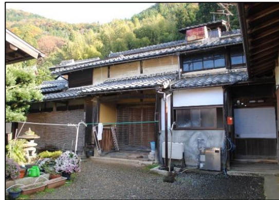
菅浦家住宅主屋 木造2階建、瓦葺 安政年間(1854~1859)建築(棟札)
