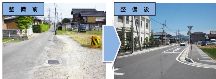
図 2-7 生活道路の改善の事例（歩道拡幅、歩道設置）
