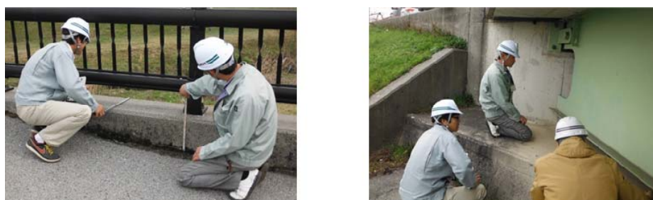
図2-25 日常的なパトロールの状況
