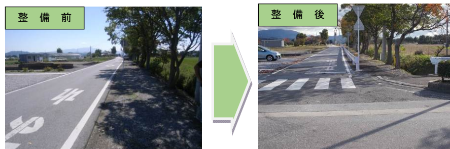
図 2-14 通学路の緊急合同点検結果を受けた整備の例（ガードレールによる歩車分離）
