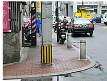
歩道の真ん中に電柱が設置
