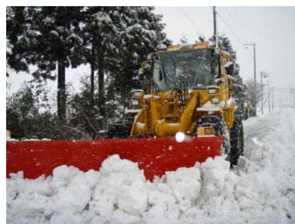
図 2-23 除雪機械による除雪
