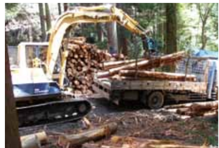
集材作業中の作業道（谷口町）
