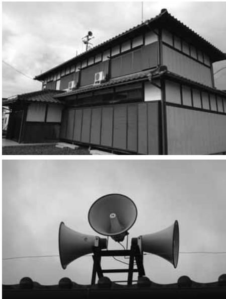
▲自治会館や広場の放送設備
