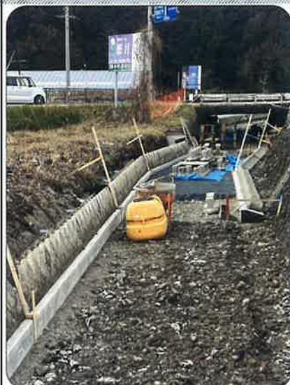
内井川改修の第二期工事が始まっています。二期工事は国道365号線今庄橋詰の信号にあるローソンの南側沿いから開始して、2月時点でおよそ90m程、進行しております。最終完成目標の北郷里井堰まで急ピッチで進められています。
