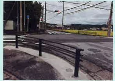
新設されたガードレール
